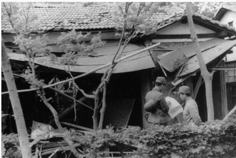
写真⑤ 20.3 1トン爆弾の爆風と土砂で破壊された民家
